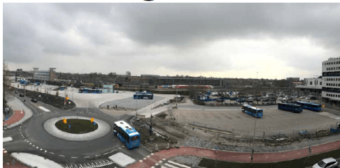
Voor het busstation is ongeveer 7.500 m 3 beton gebruikt. Dat is drie keer een olympisch zwembad vol!
