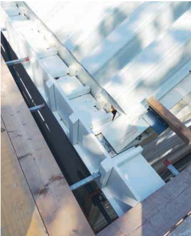
Hemelwater gaat via de verholen goten richting afvoeren in de spouwen.
