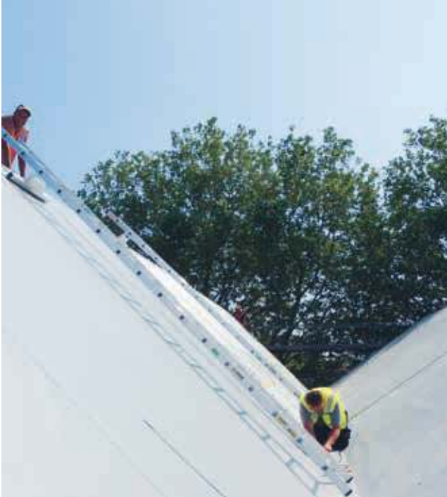
Om veilig en efficiënt te werken, gebruiken dakdekkers speciale, op maat gemaakte ladders.
