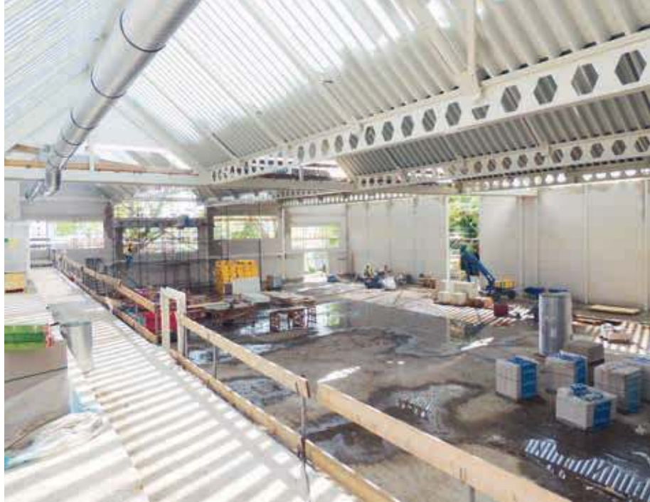
De kappen van de sporthal en andere ruimtes worden akoestisch uitgevoerd. In de cannelures van de geperforeerde geprofileerde stalen dakplaten komt geluiddempende minerale wol. Het dak van de sporthal wordt voorzien van drie ramen van 2900 bij 1750 mm.
