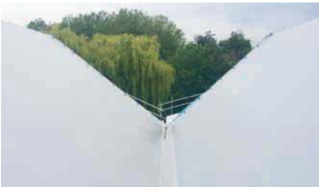
In totaal wordt ongeveer 3.450 m 2 bedekking aangebracht.
