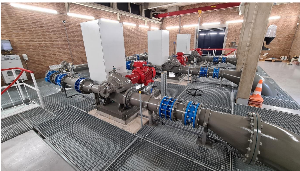
Figuur 6 De nieuwe pompinstallatie in aanbouw en de nieuwe vlakke vloer
