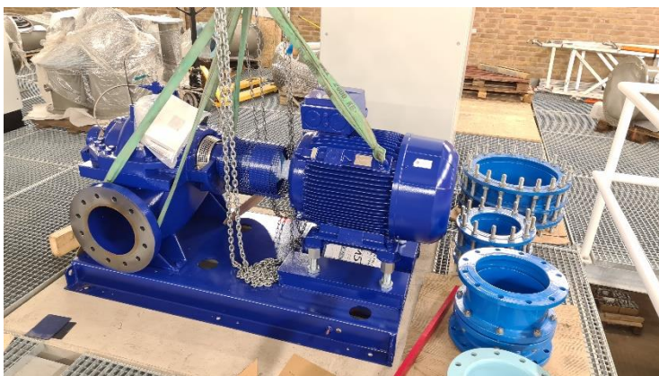
Figuur 5 Installatie van een nieuwe pomp
